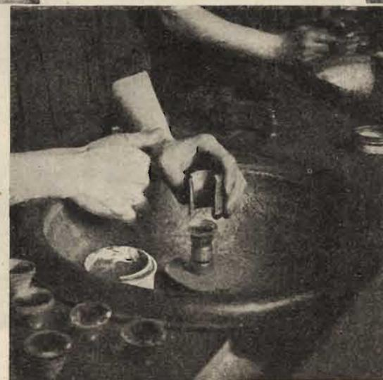
poste ad una vite micrometrica per il rilievo e la correzione degli ultimi difetti. — Fig. 3 (a destra). Incolatura delle ultime due lenti dell'obbiettivo: su una delle due lenti, mantenuta calda, si versa una goccia di balsamo del Canada, che è trasparentissimo, e vi si comprime sopra l'altra lente sino a perfetta adesione. — Fig. 4. Ultima arrotondatura delle lenti.
