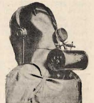
bilità della respirazione è mantenuta a lungo da un apparecchio a svolgimento d'ossigeno situato nel cilindro visibile della figura il quale contiene pure calce per l'assorbimento dell'anidride carbonica dell'inspirazione.
