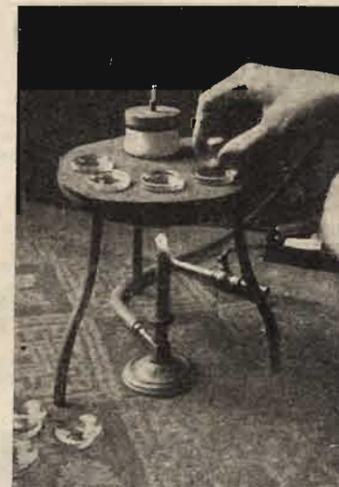
Fig. 1. Lenti abbozzate su calotte sferiche: la curvatura delle calotte è di raggio uguale a quello delle lenti che si vogliono ottenere; l'adesione delle lenti alle calotte si ottiene con spalmatura di catrame leggermente rammolito alla fiamma del gas. — Fig. 2 (a sinistra). Centratrice delle lenti: mantenute calde su di un minuscolo treppiede a punte d'osso, le lenti vengono ad una ad una sotto-
